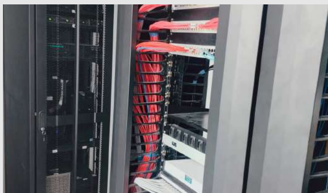
Construção do novo CPD (Centro de Processamento de Dados)
