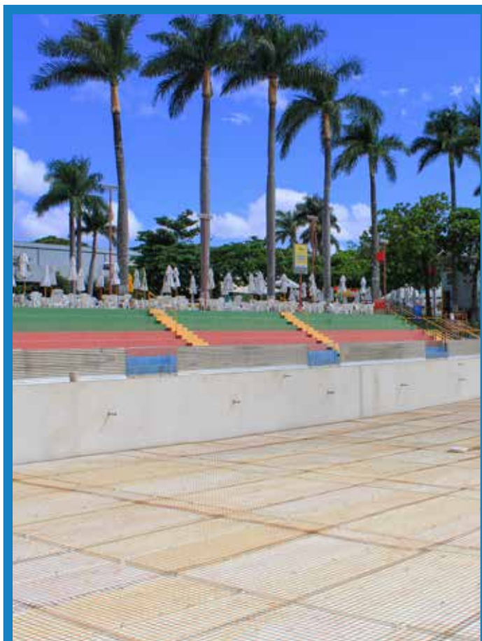
Reforma Piscina Olímpica
