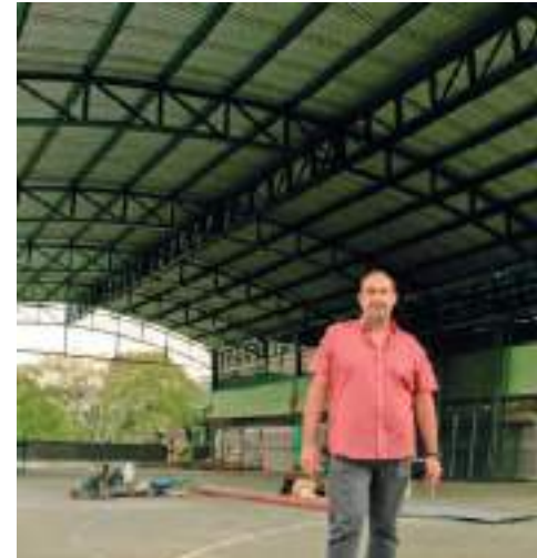
Diretor Flaiton na reforma da quadra poliesportiva.
