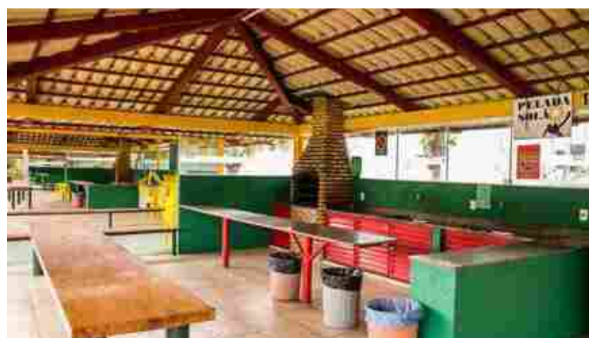
Reformas nos Quiosques
