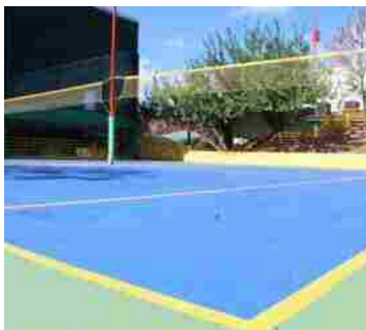
Reforma Quadra de Peteca
