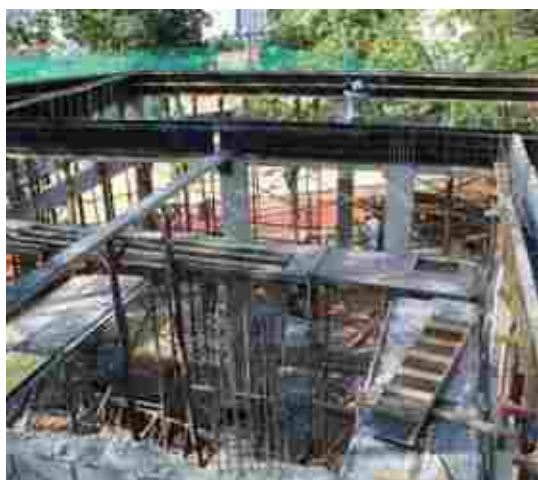
Construção de duas novas Quadras de Squash
