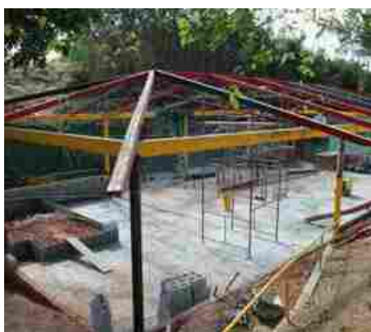
Reformas nos Quiosques
